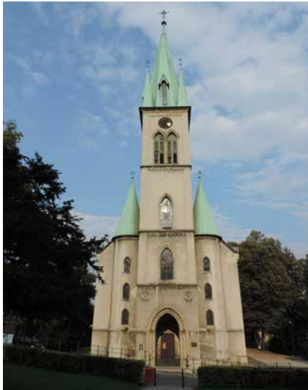
Bielski Syjon Kostol Spasiteľa, Kościół Zbawiciela, the Church of the Saviour, die Kirche des Erlösers, GPS 49°49'22,11"N 19°02'27,47"E
